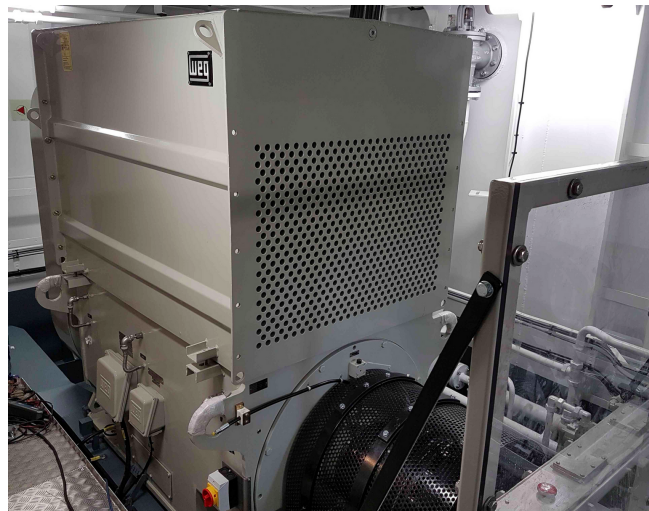
De elektrische motor die de hydraulische lieren aandrijft. Bron: Damen Shipyards.
