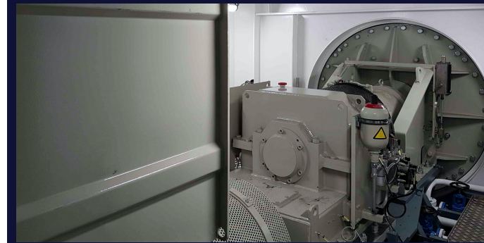
De elektrische motor die de baggerpomp aandrijft.
